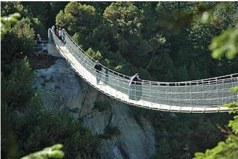
Une jetée renversante avec des barres sécurisées: le pont à la main de côté.
