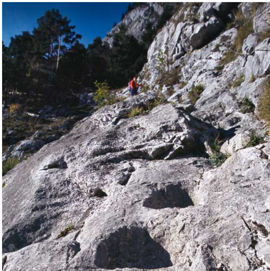
Les marches ont été taillées dans la roche par Gottfried Lüthi, garde forestier et garde-chasse, et ses quatre camarades entre 1932 et 1934. Pour 90 centimes l'heure, ils n'ont pas lésiné sur les coups de marteau et de burin
