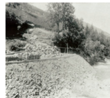
Construction du barrage en 1908
