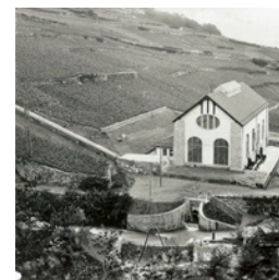
Usine électrique et prise d'eau pour les Meunières en 1910
